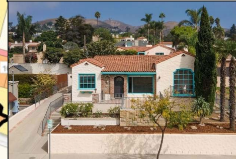
T4.1-2 (urbana general: Calle principal/Fachada del lado oeste) residencias de baja altura de 2 a 3 pisos y usos al servicio del vecindario
